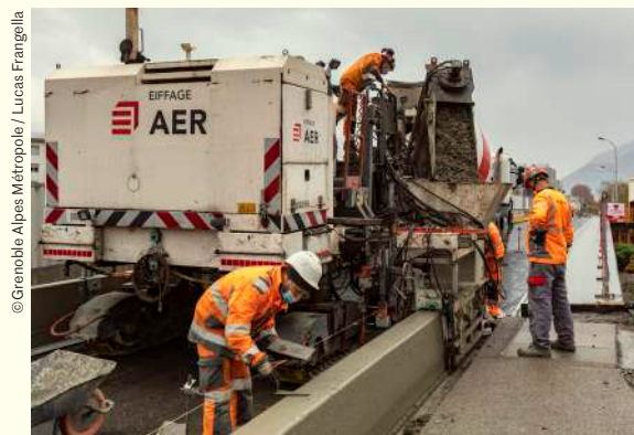
Le pont Potié, à Saint-Martin-d'Hères, a réouvert début 2022 après plus d'un an de travaux.
