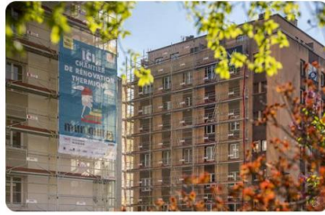
Isoler une copropriété avec Mur Mur
