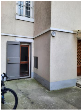
Entrée local 1 par cour commune
