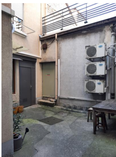
Accès par cour commune
