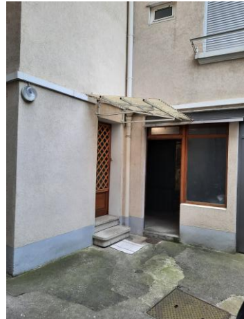
Entrée local 2 par cour commune
