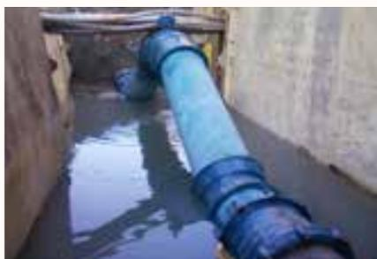
← Remplacement d'une conduite percée
