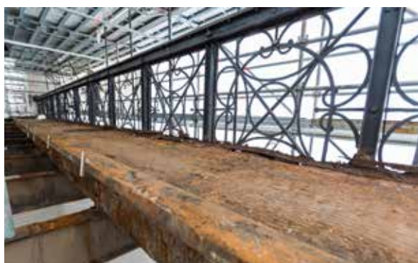
Poutrelles affaiblies, garde-corps rongés, boulons usés... Au cours des décennies, la corrosion avait largement fait son œuvre, sur l'ensemble des pièces métalliques de la structure.
