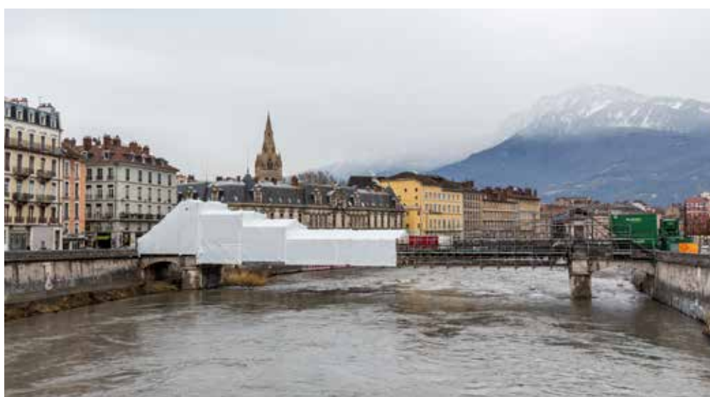
Installation de la bâche de confinement.
