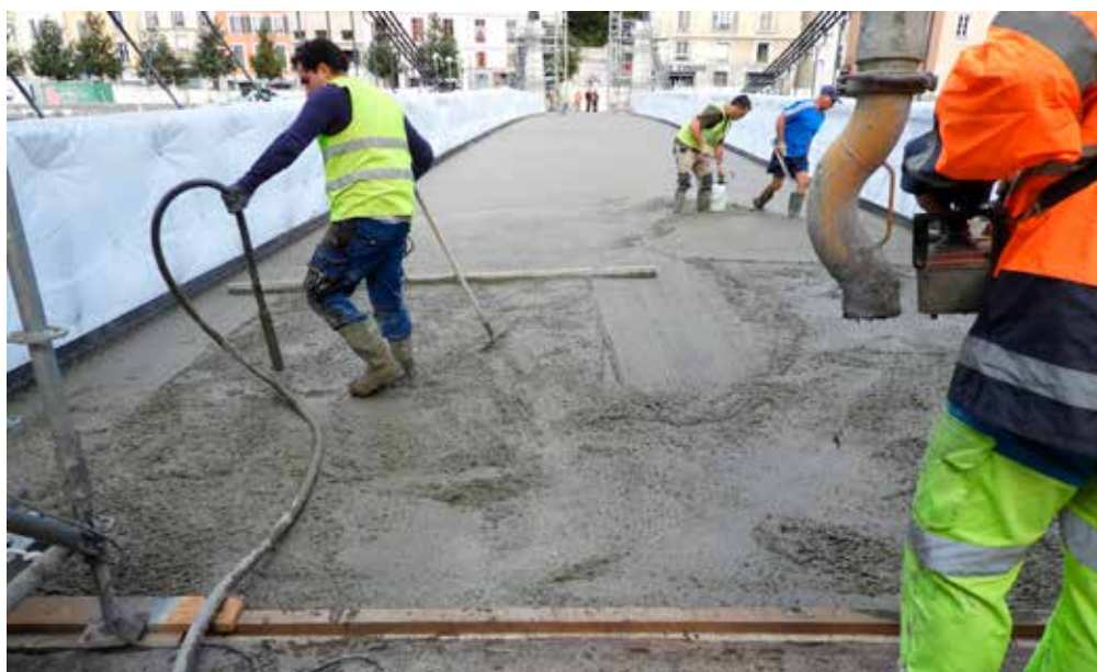
Derniers travaux de revêtement du tablier.
