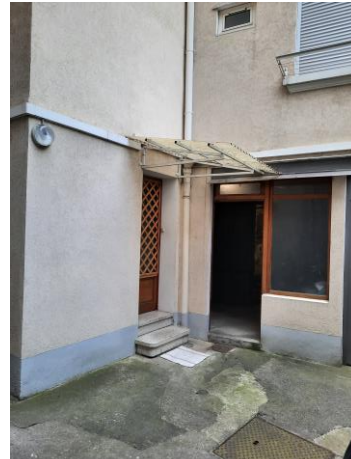
Entrée local 2 par cour commune
