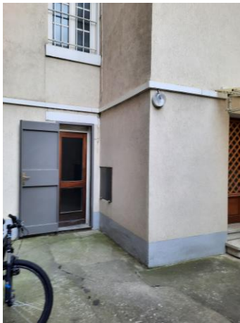
Entrée local 1 par cour commune
