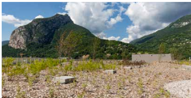
Un toit-terrasse végétalisé de 1 800 m 2
