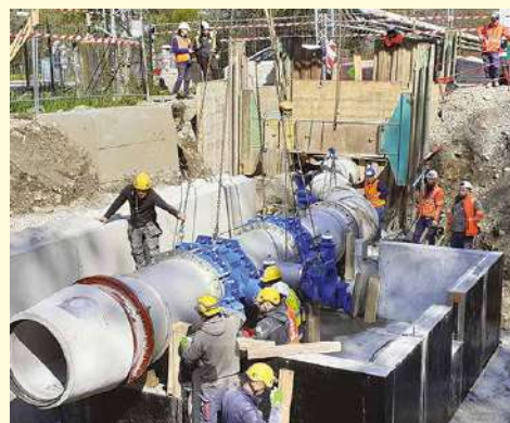
Travaux au Pont-de-Claix sur la canalisation qui achemine l'eau de la nappe phréatique de la Romanche vers les communes de l'Est de la Métropole et du Grésivaudan.
