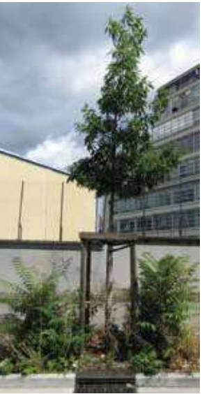
Bordure haute rue Lanoyerie, Grenoble. Attention, les av- loirs pour les eaux pluviales sont à disposer à l'entraxe* de l'arbre. A noter la présence de plantes exotiques envahis- santes, les ailanthes, en pied d'arbre.
